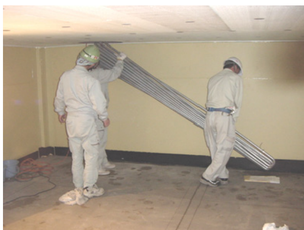
現場組立型ブライン方式アイスチラー ® 氷蓄熱コイルの部材搬入状況
