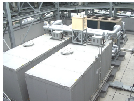
ブライン方式アイスチラー® 氷蓄熱パッケージ設置例
