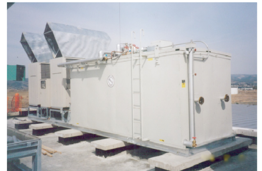
直膨方式アイスチラー® 氷蓄熱パッケージ設置例
