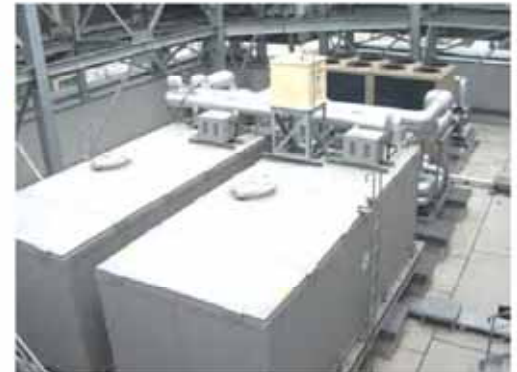
ブライン方式アイスチラー ® 氷蓄熱パッケージ設置例
