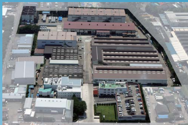
製品製造工場：新晃空調工業株式会社 神奈川工場
