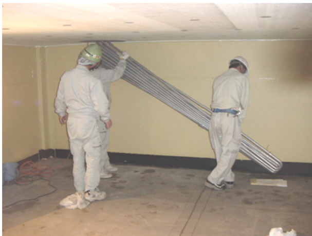
現場組立型内融式アイスチラー ® コイルの部材搬入状況
