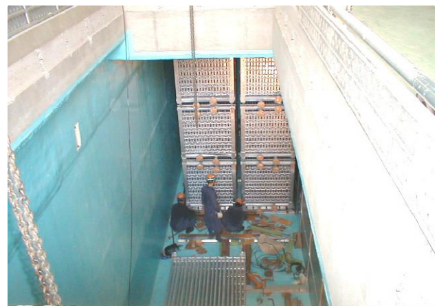
コンクリート水槽設置例
