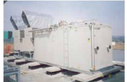
直膨方式アイスチラー® 氷蓄熱パッケージ設置例
