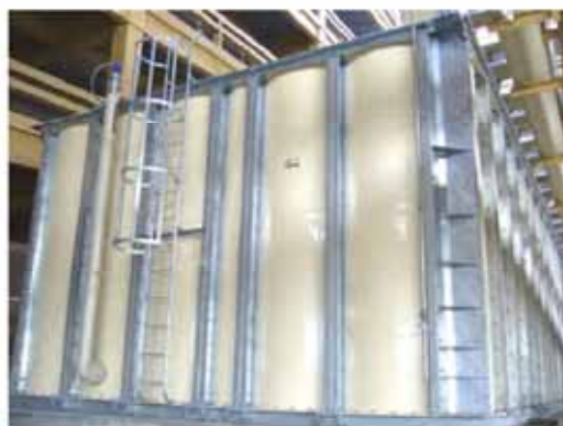
FRP製水蓄熱槽設置例
