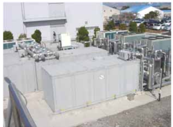
アイスチラー®氷蓄熱ユニットのブライン配管施工例
