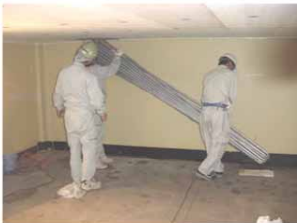
現場組立型内融式アイスチラー ® コイルの部材搬入状況
