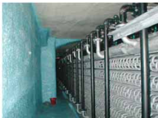
現場組立型アイステラ®水蓄熱コイル設置例
